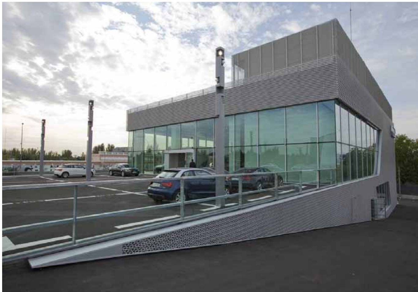
Vista trasera del Audi Center Madrid Las Rozas con el aparcamiento para clientes situado en el piso superior.
